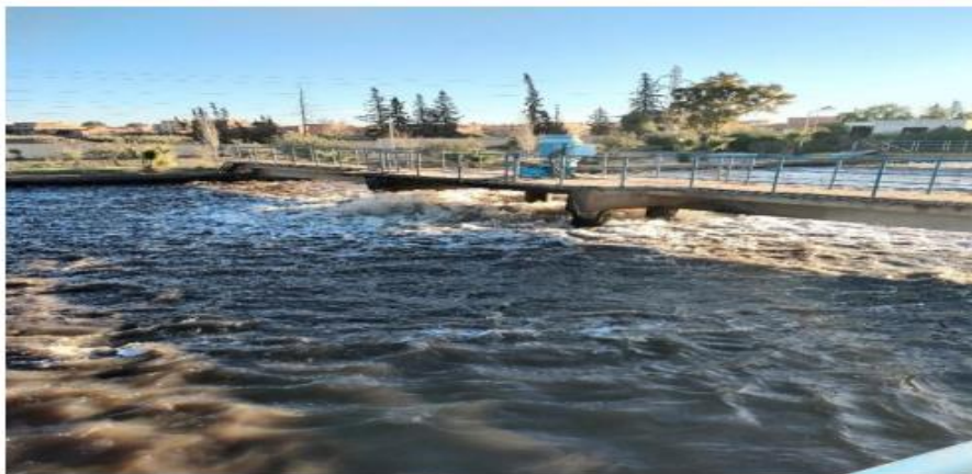
Fig. 04 : Bassin d'aération. (Station de Saida : Janvier 2022)
