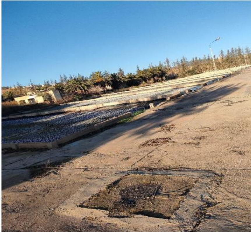
Fig. 10 : Les lits de séchages (Station de Saida : Janvier 2022)
