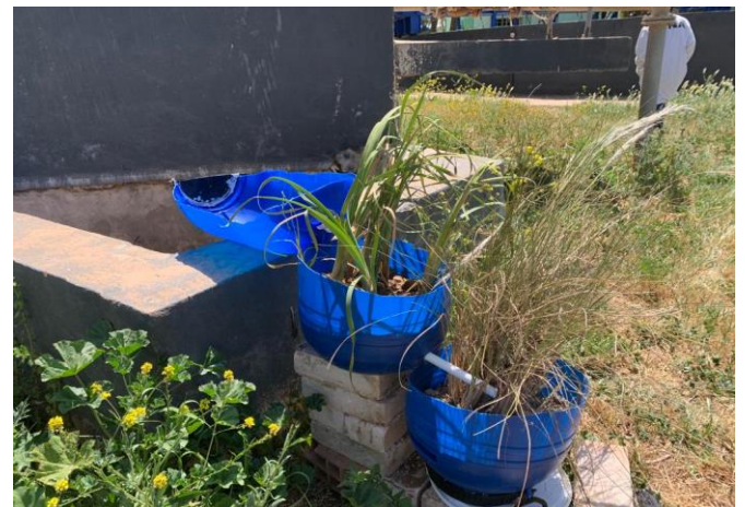
Fig. 58 : dans cette étape les eaux usées sont filtrées pour une 2eme fois pour obtenir une eau épurée s'évacue à un autre récipient
