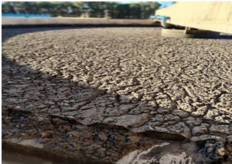
Fig. 09 : Épaississeur (Station de Saida : Janvier 2022 )
