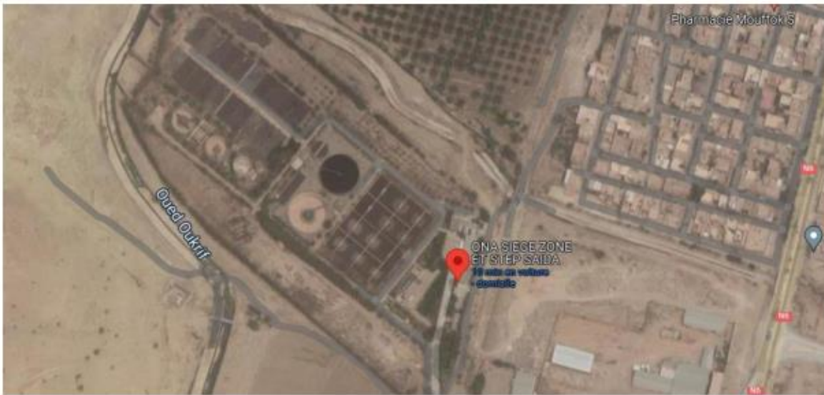
Fig. 38: La Station d'épuration à boues activées (Google Earth 2022).
